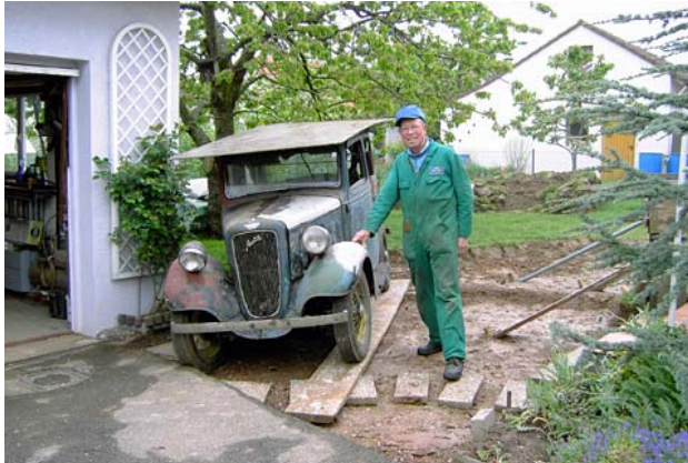
15) ...eine Baustelle kommt selten allein
