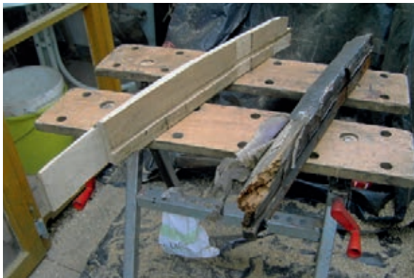
16-17) Präzisionsarbeit in Eichenholz. Zum Schluss machte der gute Winkelschleifer mit einer groben Fiberscheibe alles schön glatt und passig.
